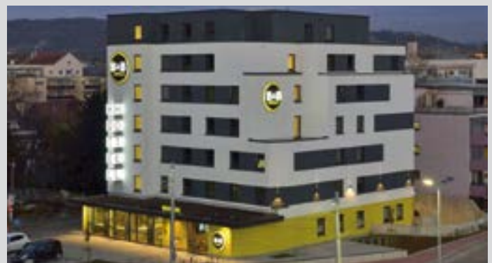
Tramanschluss in die Innenstadt: Das Hotel B&B in Weil am Rhein bietet Gratisparkplätze und komfortable, klimatisierte Zimmer ab 60 Euro pro Nacht.
