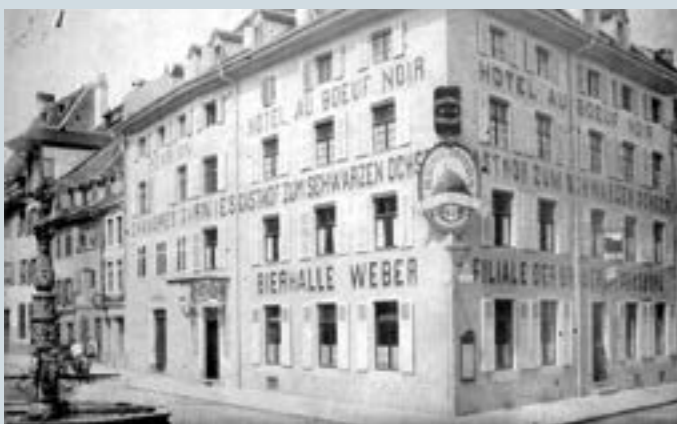
Beim Spalenbrunnen: Bierhalle Weber / Gasthof zum Schwarzen Ochsen (1890)
